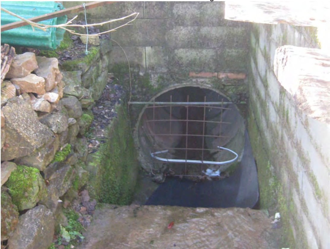
Fosso di Via Marconi – imbocco del tombamento
