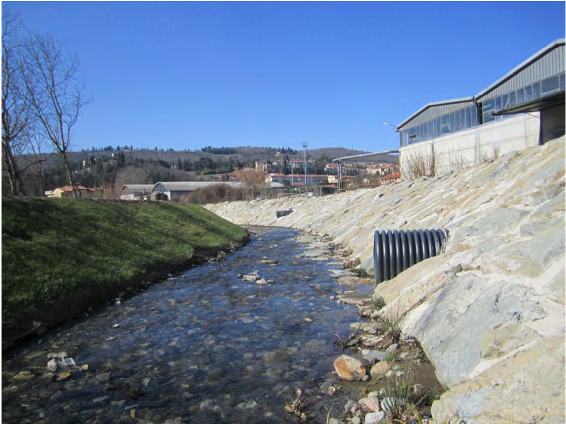
Sbocco del tombamento nell'alveo del Borro Grande
